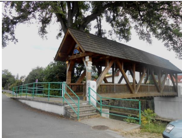
Zastřešení přes jednoduchý most (pod ním je voda) → zastřešení.
