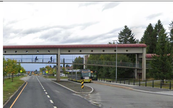
Zastřešení přes most (je možné pod ním projít) → zastřešení může být vypuštěno, jsou mapovány dvě úrovně.
